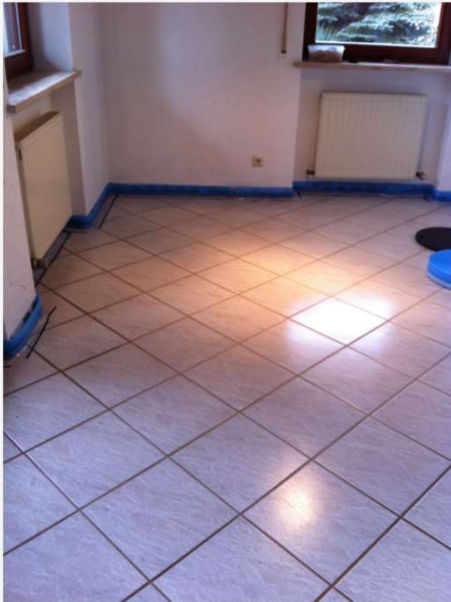
Verlegen der Randdämmstreifen
