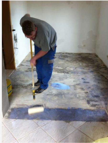
Vorbehandlung des ursprünglichen Fußbodens mit Haftgrund
