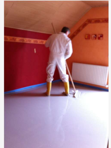
Einbringen des Carbonestrichs
